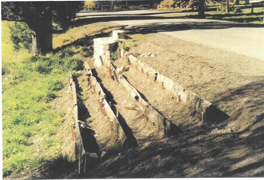
Figura 38: Control de erosión en taludes. Aterrazado etapa constructiva. (Parque Nacional Loa Alerces)
