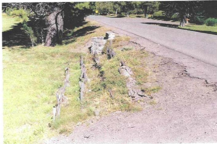
Figura 39: Control de erosión de taludes. Aterrazado luego de un año.(Parque Nac. Los Alerces)
