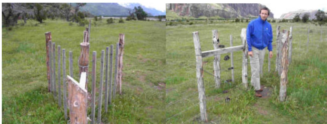
Figura I: Un ejemplo del paso C construido en las cercanías del Chaltén. Para garantizar su eficacia en el cruce de huemules en cuatro direcciones, se debe construir una estructura simétrica y enfrentada a continuidad de la que se muestra en las fotografías. Adicionalmente se puede reforzar con un travesaño o alambres intermedios sobre el paso para evitar cruces de animales domésticos.
