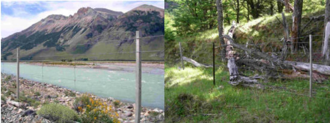
Figura II: Alambrados presentes en algunos sectores de la ruta provincial 23. Entre las características no apropiadas para permitir el paso de huemules se puede mencionar la presencia simultanea de alturas de 1,10 a 1,20 m, 7 hilos y uno adicional superior de púas, distancias reducidas del primer hilo al suelo y tensores para evitar el cruce entre hilos, entre otros.
